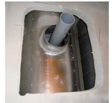
**Placer le raccord de conduit concentrique avec le manchon coupe-feu**
