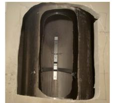
**Placer le Té de raccordement MultiFlex et le tuyau flexible MultiFlex dans le conduit existant d'évacuation des gaz de combustion**
