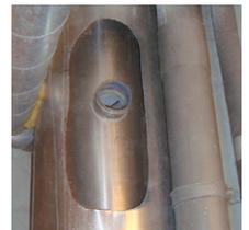
**Découper ou scier en partie la chemise du système d'évacuation des gaz de combustion et placer le collier spécial**
