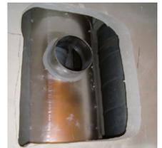
**Placer le conduit d'évacuation des gaz de combustion Ø 60 mm sur le té de raccordement**
