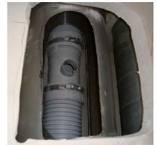
**Fermer le conduit d'amenée d'air avec une plaque de recouvrement**
